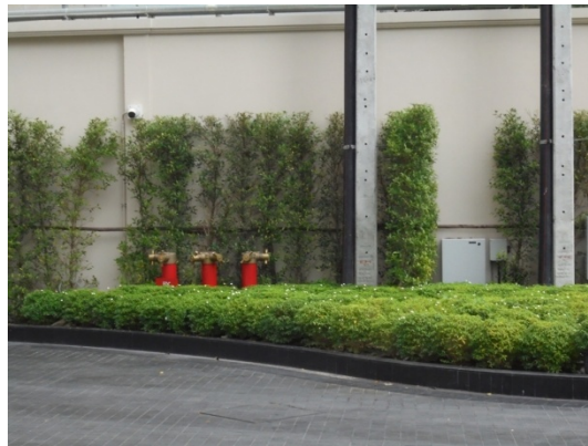
ภาพที่ 3-28 หัวรับน้ำดับเพลิงจากภายนอกและจุดรวมพล
