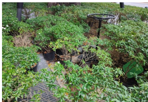
ภาพที่ 3-19 บ่อตรวจคุณภาพน้ำฝาทะแกรงเหล็ก และภายในมีตะแกรงดักขยะ
