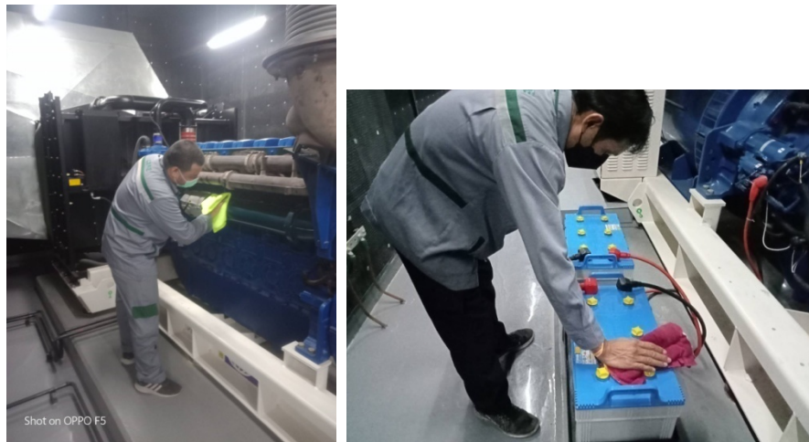
ภาพที่ 3-35 ตรวจสอบและซ่อมบำรุง Generator
