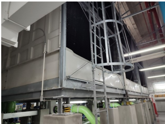
ภาพที่ 3-4 ระบบหล่อเย็นของโครงการ Cooling Tower และการบำรุงรักษา
